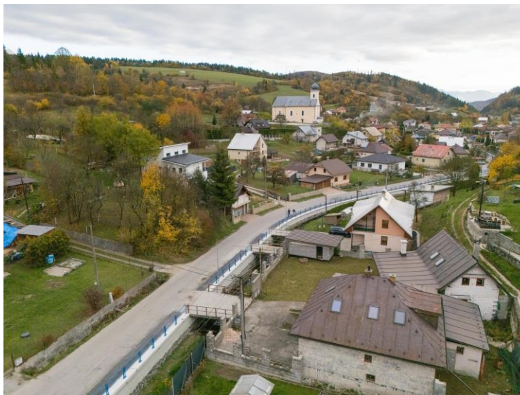
Obrázok 3 – Rekonštrukcia oporný múr cesta III/2093, celková dĺžka 455 m
